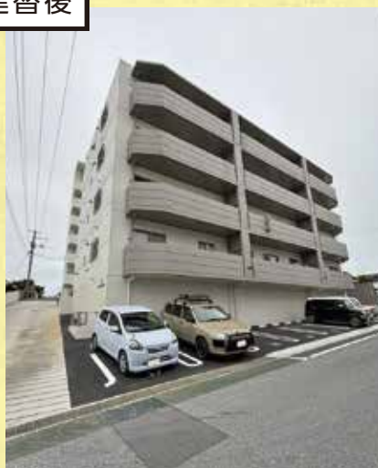
老朽住宅を解体し、新築住宅等取得補助金、建物除却補助金を活用し、令和6年度に共同住宅を建設
