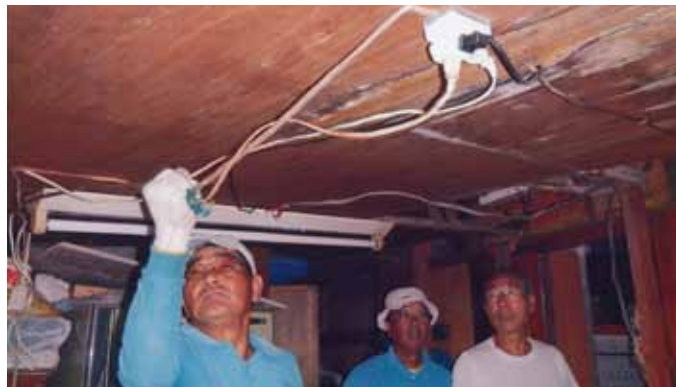
▲住宅での作業の様子
