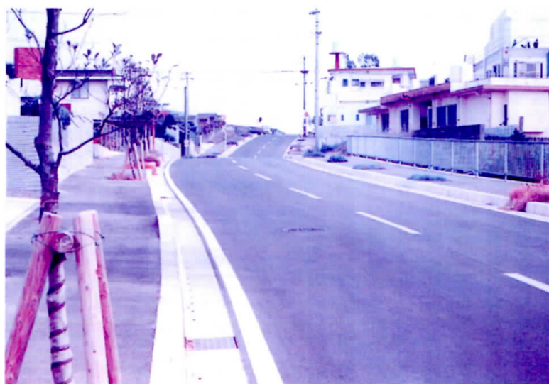
整備が進む道路（屋良・千貫田線）
