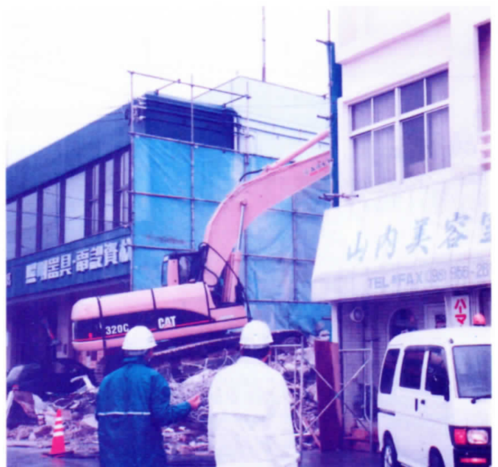
取り壊し作業が始まったロータリー内
