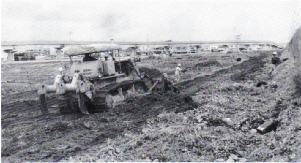
▲行政センター(役場庁舎)造成工事着工 (消防署南側・1月28日)
