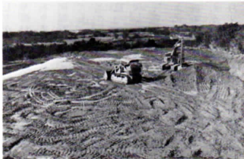
昭和54年3月の完成をめざして着工した工事現場
