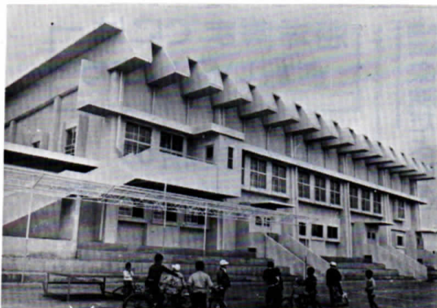
◀ 屋良小学校体育館 完成 昭和49年11月11日 工事費115,055,911円 延面積1,062,18平方米
