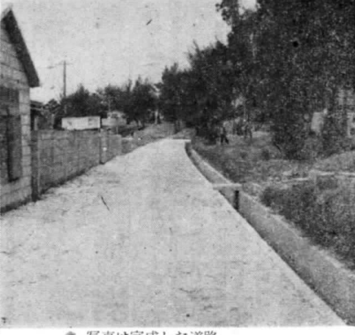
写真は完成した道路
